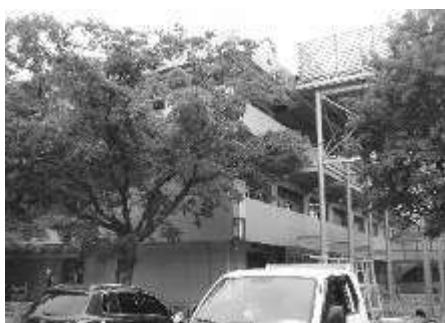
改築が進むアダプテッドスポーツ教育研究施設
