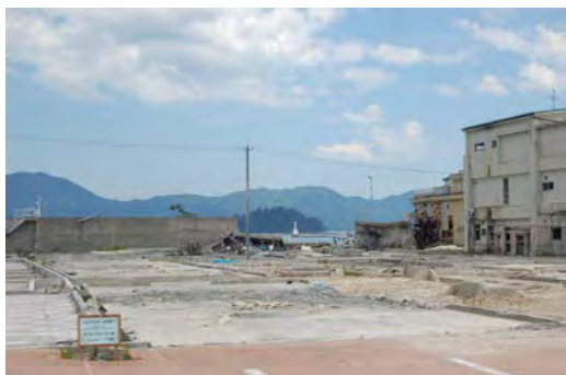
写真7 山田町の決壊した防潮堤
